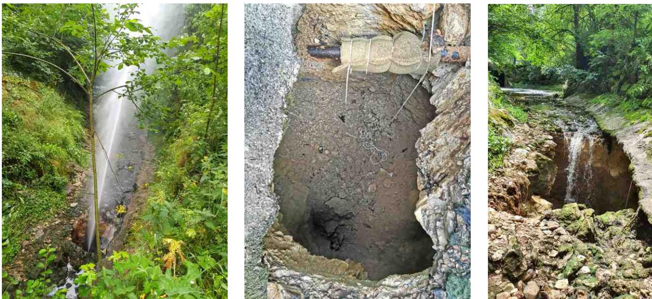
La conduite d'eau percée et le trou béant provoqué par l'effondrement, situé directement dans le lit de La Ronde.
